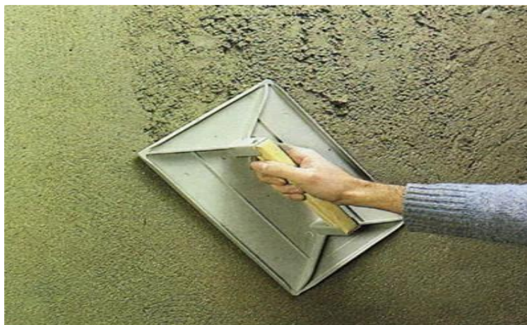
Figure I.10 : Enduit de mortier de façade
