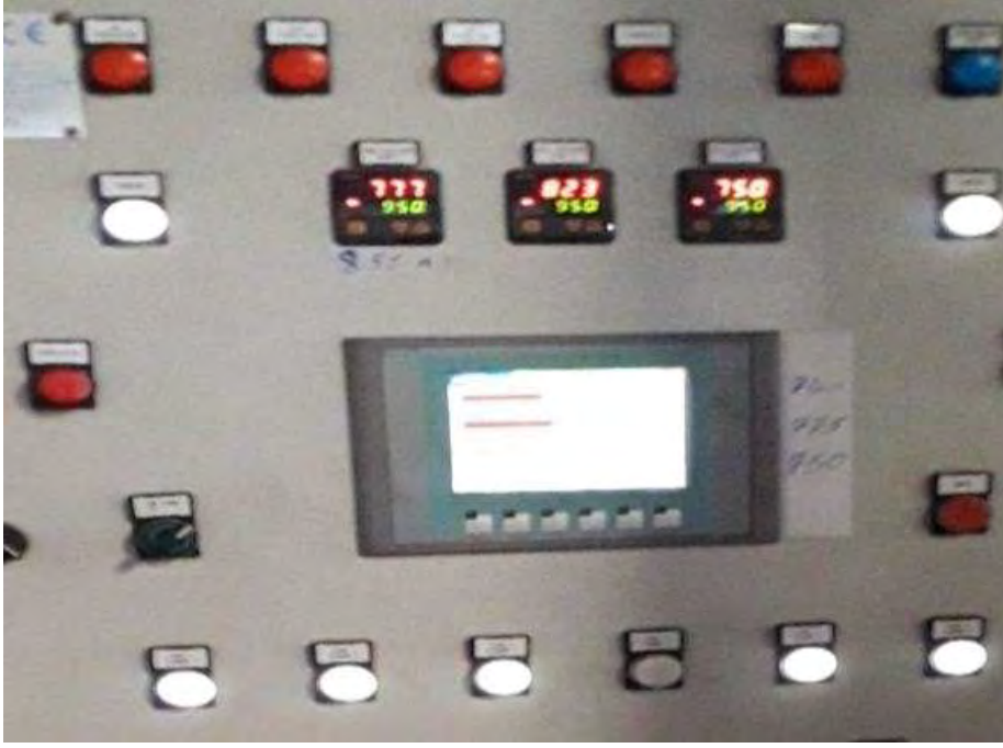
صورة رقم (02) توضح لوحة التحكم في درجات الحرارة في الفرن لتحويل المعادن.
