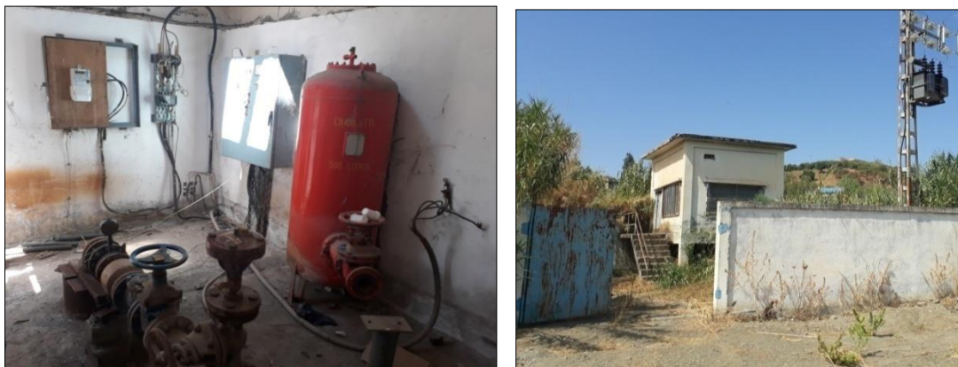
Figures (II .3) : Etat général du forage AZ2
