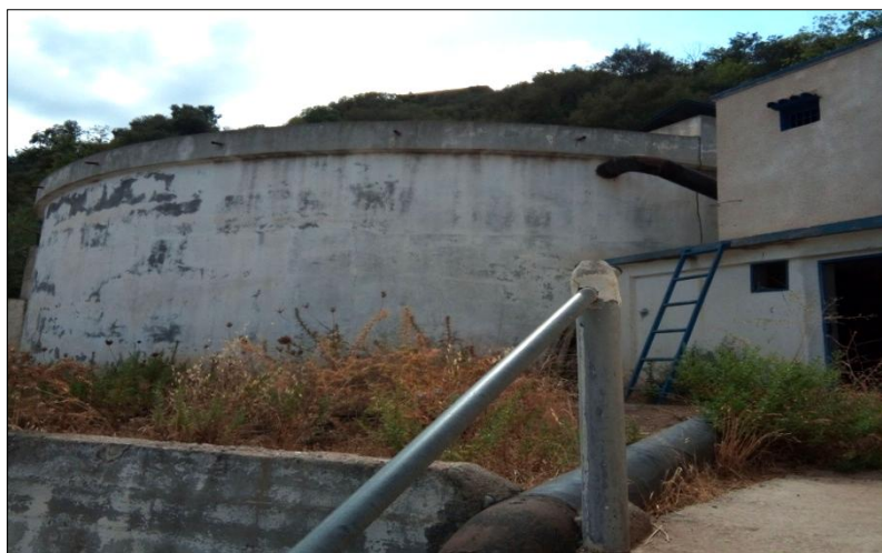
Figure (II.13): Etat général du site de la station de reprise (SR 2 )
