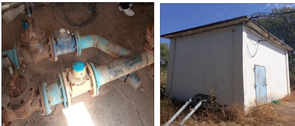
Figures (II .6) : Etat général du forage AZ8
