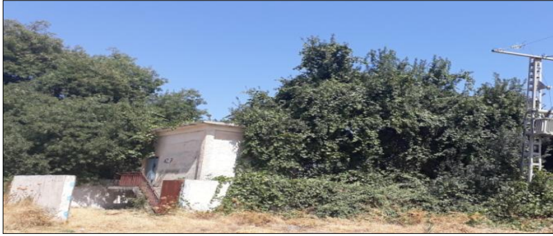
Figures (II .4) : Etat général du forage AZ7
