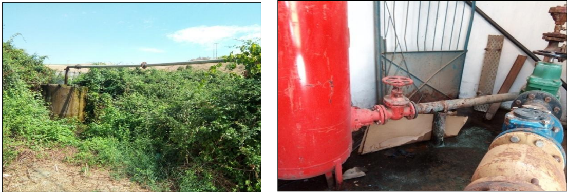
Figures (II .5):Etat général du forage AZ7
