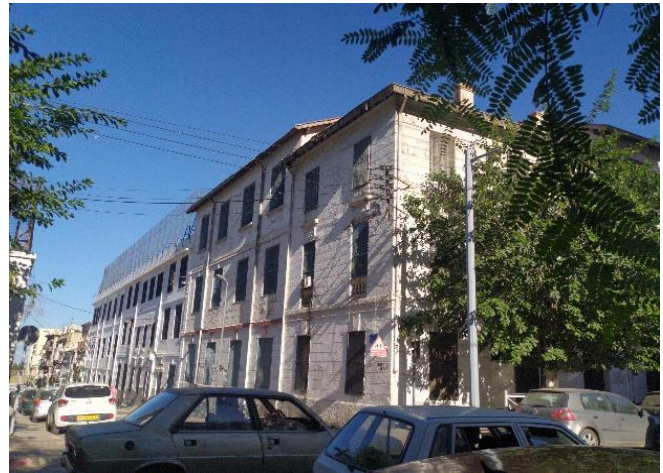
Photo 5 : Ancienne usine SNTA, (source : auteur)
