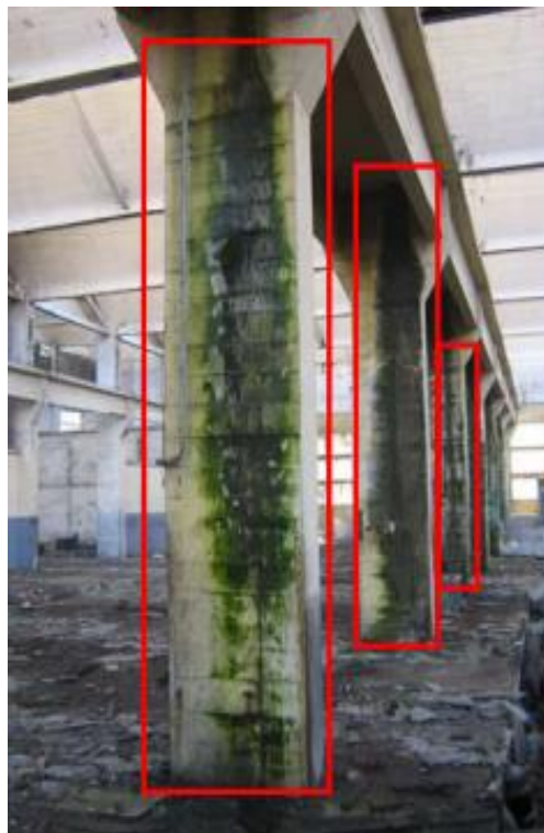
Photo 26 : Moisissures et prolifération de mousses. (Source : mémoire de magister, Samia Bouaziz, 2011)
