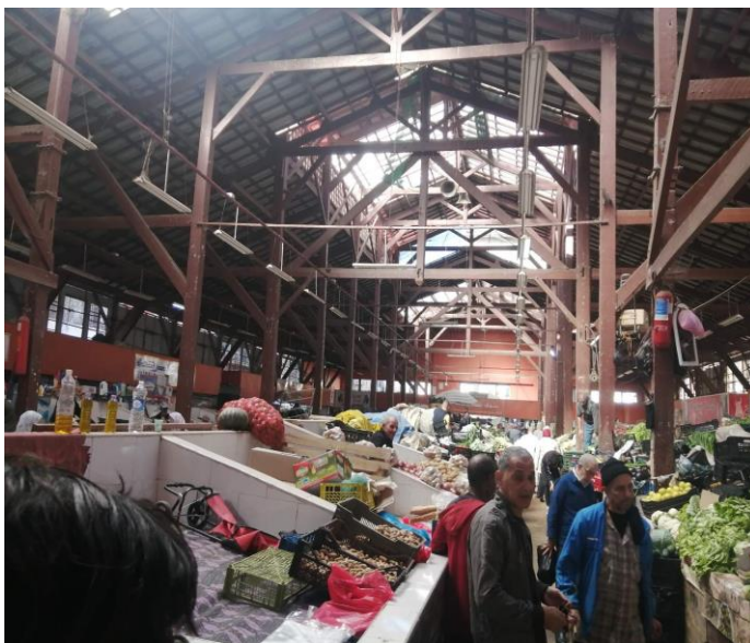
Photo 41 : l'intérieur du marché 12 (Source : auteur)
