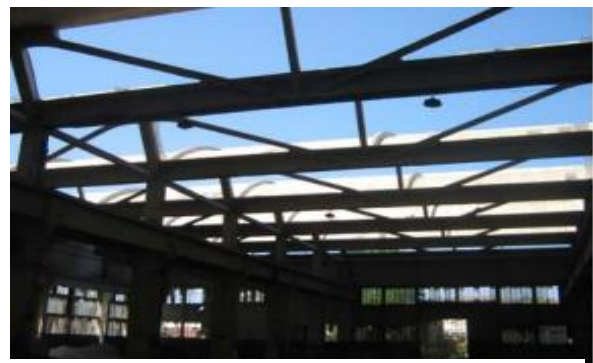
Photo 19 : Vue sur les toitures en shed et la qualité lumineuse offerte, (Source : Samia Bouaziz, mémoire de magister,2011)
