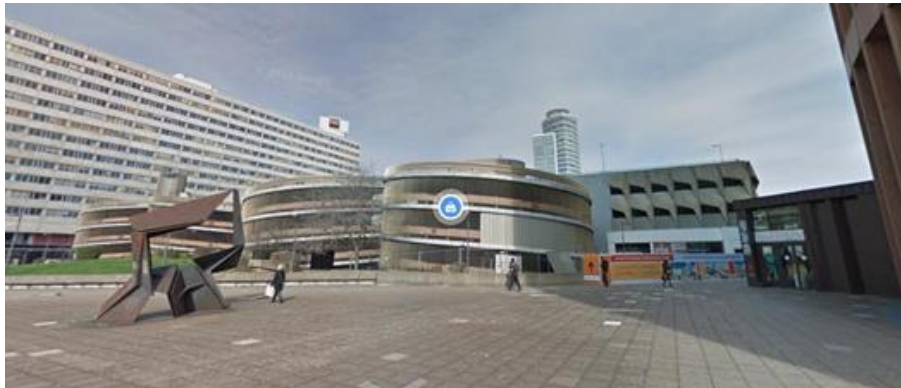
Figure 59 : Rampes de l'ancien parking. (Source : google maps)
