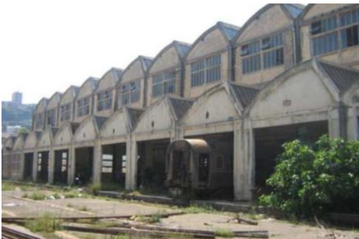
Photo 14 : Ateliers de réparation SNTF, (source : auteur)
