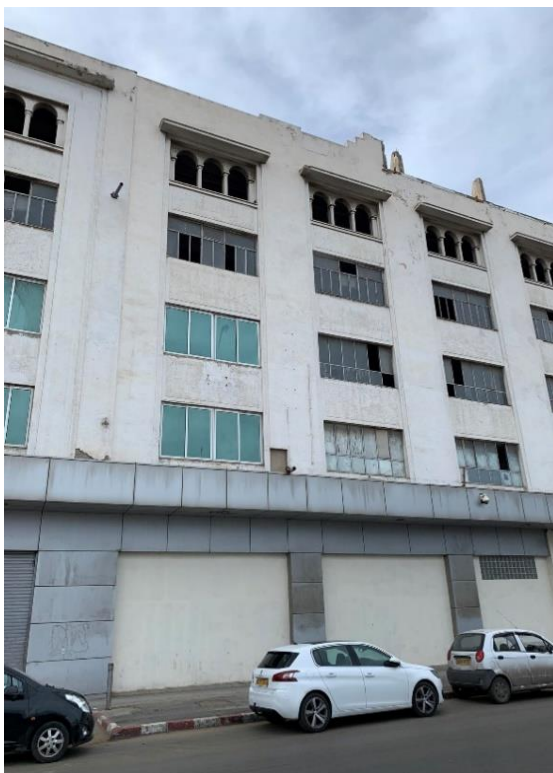
Photo 6 : ancien siège commercial et parking SONACOM. (Source : auteur)
