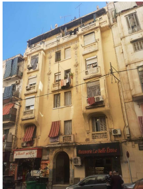
Photo 3 : habitat collectif. (Source : auteur)
