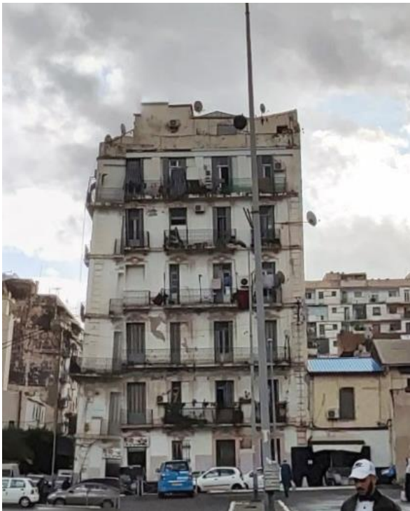
Photo 2 : habitat collectif. (Source : auteur)
