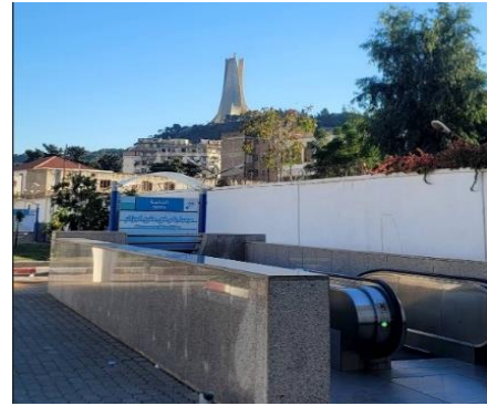
Photo 13 : L'arrêt métro El Hamma. (Source : auteur)
