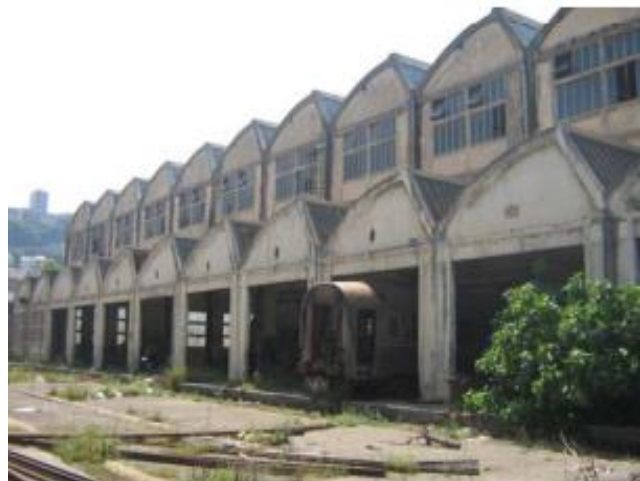
Photo 16 : Vue d'ensemble sur le bloc A Vue sur la façade Est du bloc B (Source : Samia Bouaziz, mémoire de magister,2011)
