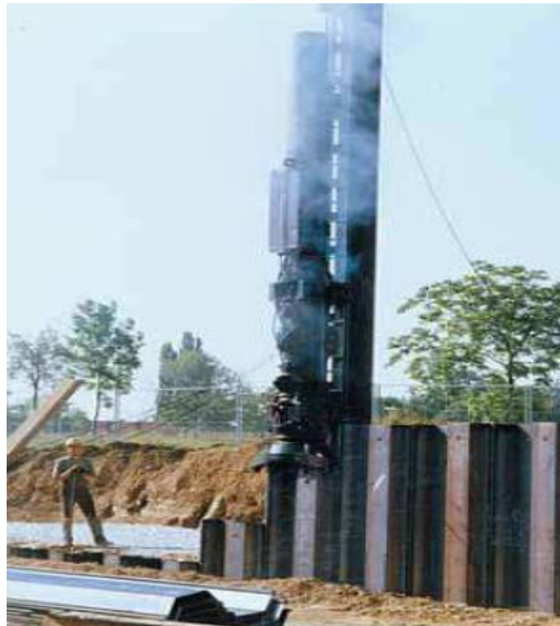
Figure 2.4. Battage Guide Technique (Laboratoire Cental des ponts et Chaussées, 2003)
