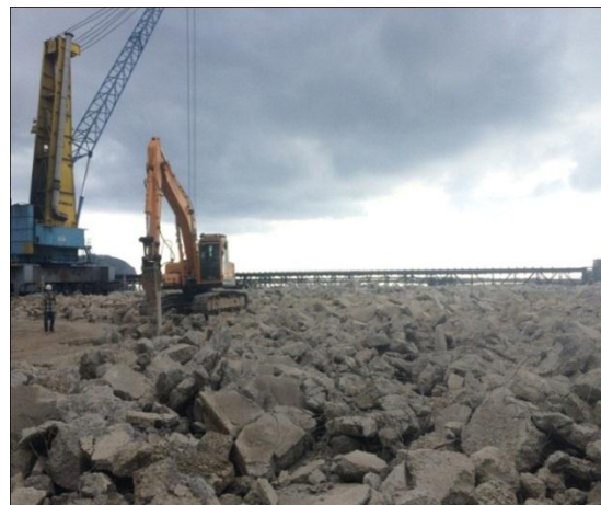
Figure 3.18. Démolition de la plateforme existante
