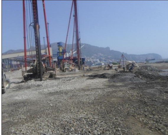
Figure 3.21. Consolidation de sol colonnes ballastées
