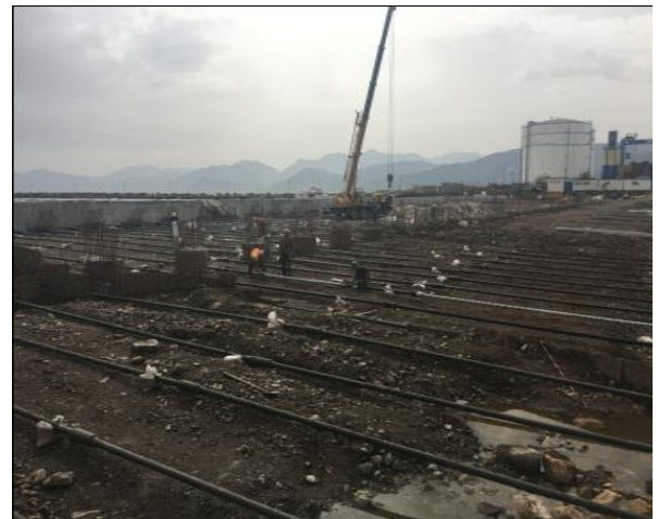
Figure 3.22. Mise en œuvre des tirants d'ancrages
