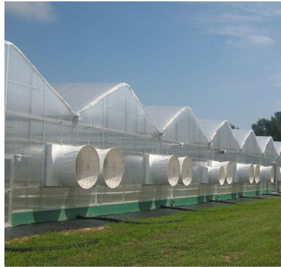
**Figure (I-6) : Aérations mécanique des serres**
