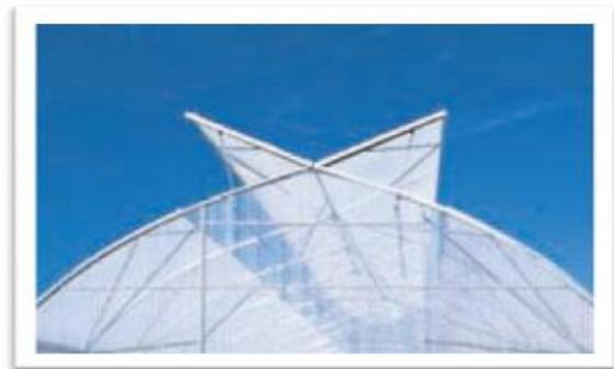
**Figure (I-5) :** Aération par double versant
