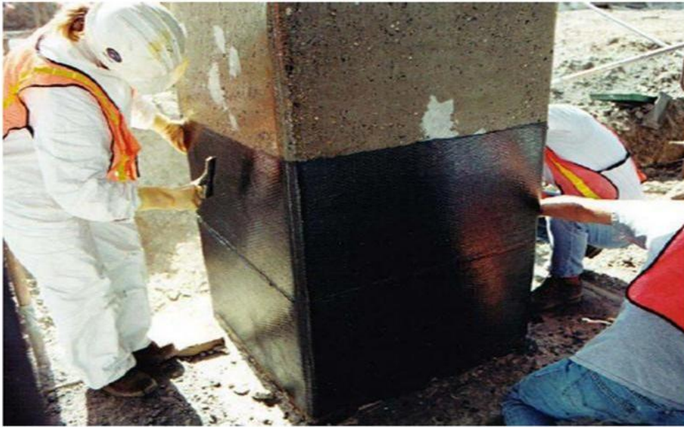
Fig. I.11. Renforcement par collage direct.[2]
