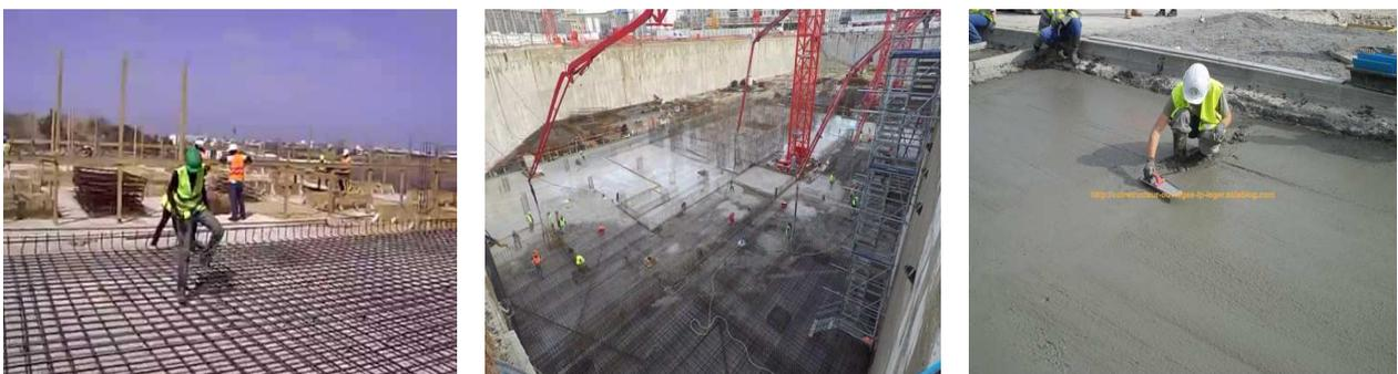
Fig: Ferrailage, Coulage et Lissage du radier.
