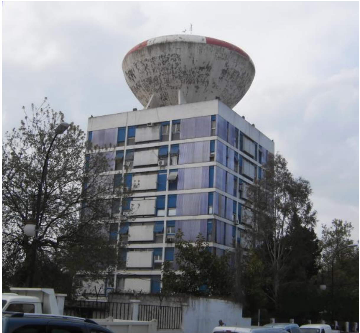
Figure II.2 : vue générale de l'ouvrage
