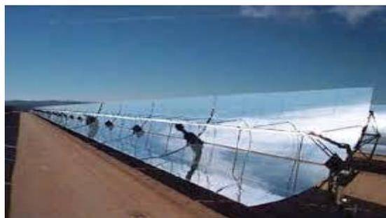
Figure II.10 : concentrateur cylindro-parabolique
