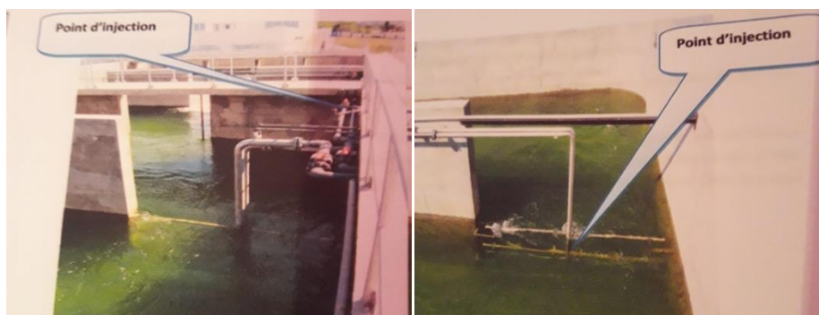
Figure 9 : Points d'injection d'acide sulfurique et de sulfate d'alumine respectivement
