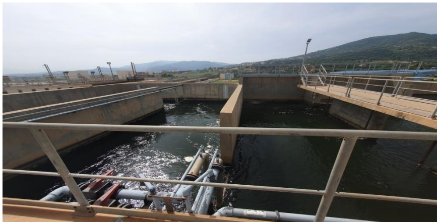
Figure 8 : Chambre de mélange
