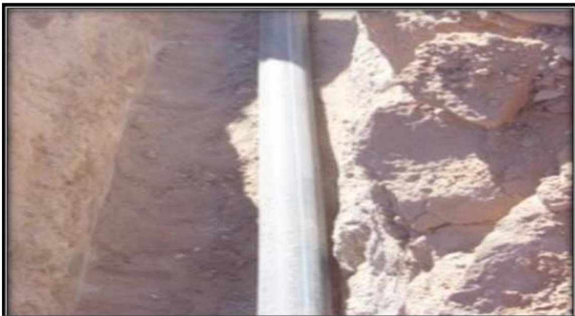
Figure VI.1.1 Pose des conduites en terre
