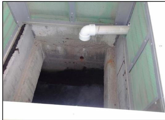
Cuve de contact pour la post-chloration
