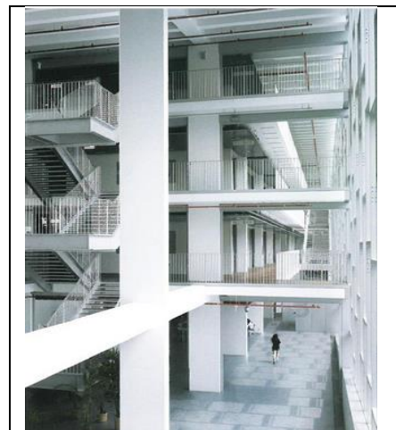
fig157 : Coursive de circulation sur la façade, source: Dominique Perrault, andrea Zamboni, édition ACTE SUD, août 2010, photographie: Andreas Solaro, p63.
