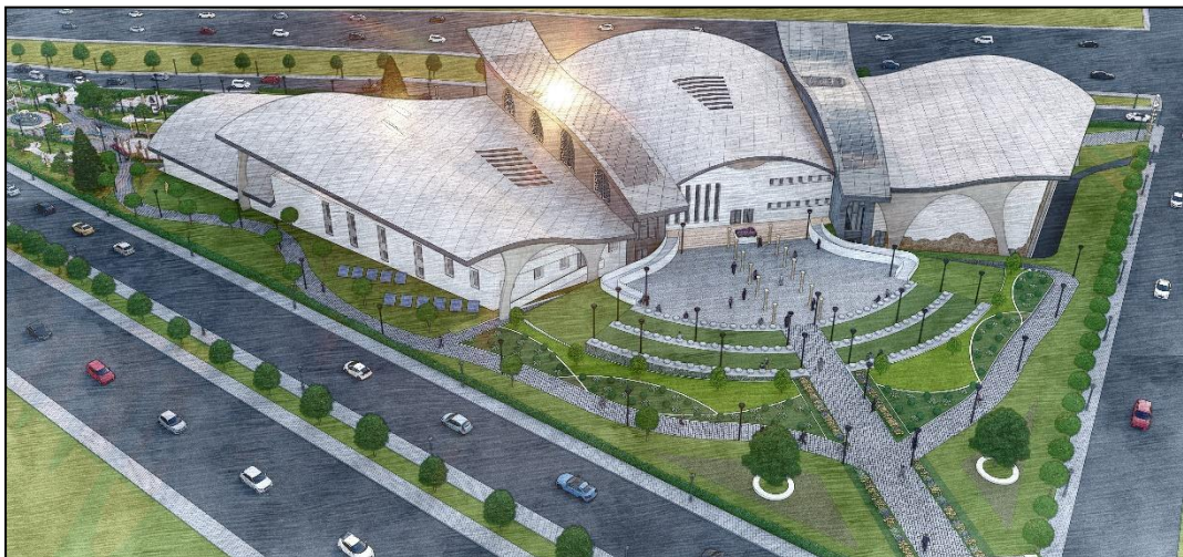
Figure 163: Accès du chercheur. Source : Auteurs.
