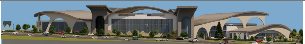
Figure 181: Façade principale du projet.
