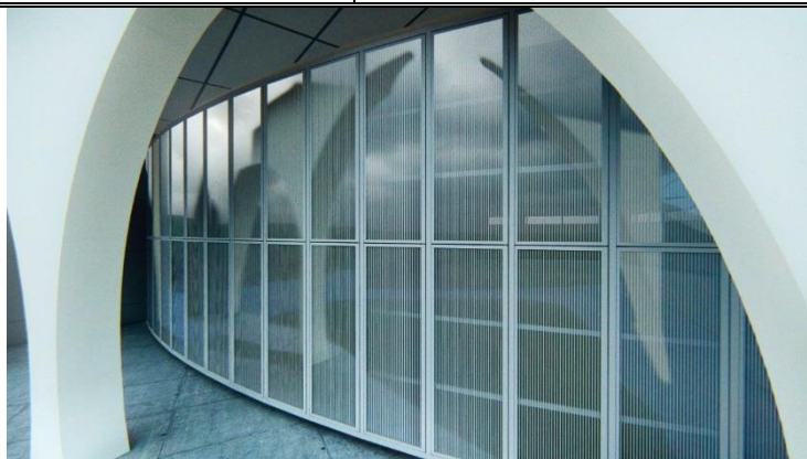
Figure 195 dans le projet.: La façade double peau. Source : Auteurs.
