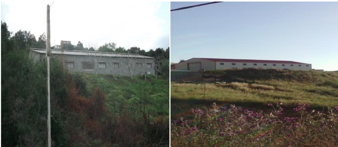
Fig. 14 - Bâtiments d'élevage des poulets de chair à Ouacif (Original 2016)
