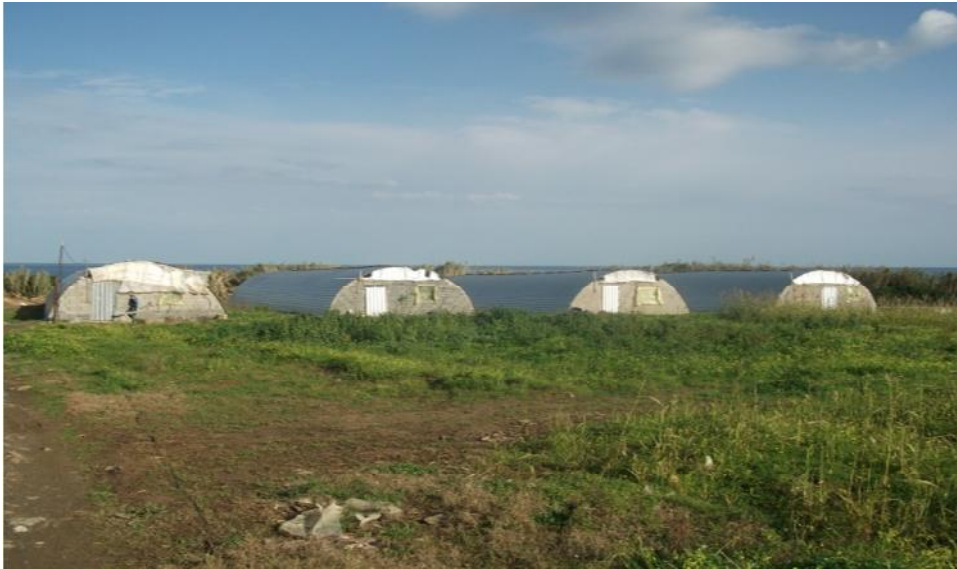
Fig. 13 - Bâtiments d'élevage des poulets de chair à Azeffoun (Original 2016)
