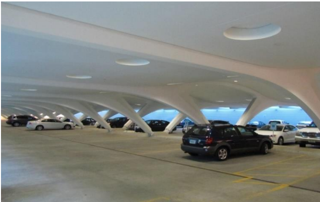
Figure V-81 : Des appuis structuraux particuliers supportent les planchers Source : www.futura-sciences.com
