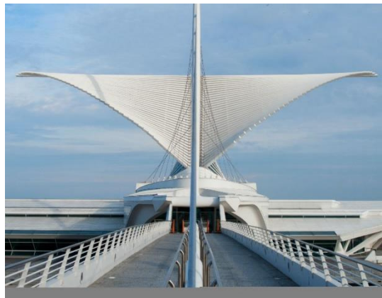
Figure V-64, V-65 : Les auvents en acier mobiles ont inspiré par les ailes d'un oiseau. Source : Solaripedia.com
