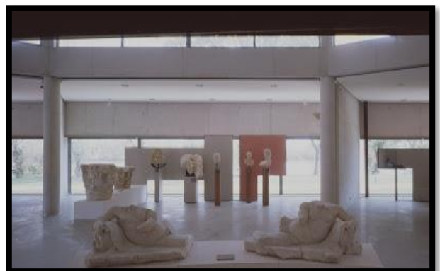
Figure V-41 : les fins poteaux
