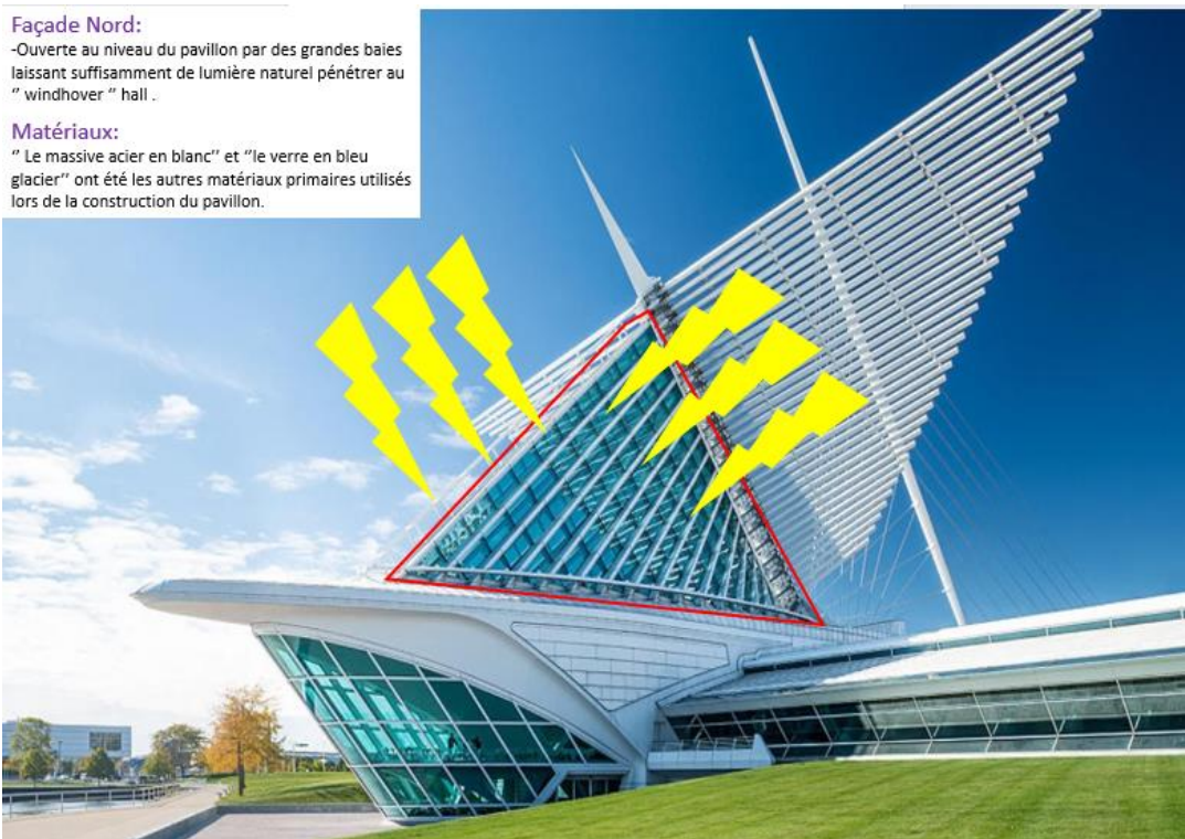
Figure V-93 : façade nord En.wikiarquitectura.com
