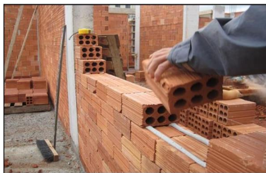
Figure VI-61 : mur en brique creuse Source : Google.com
