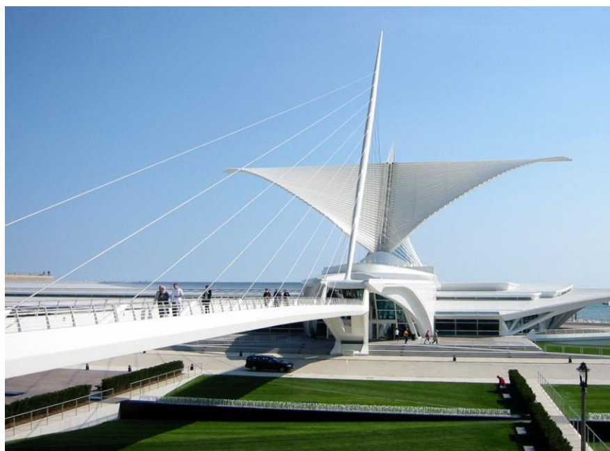
Figure V-89 : pont piétonnier En.wikiarquitectura.com
