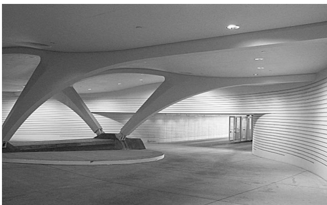
Figure V-82 : Des appuis structuraux particuliers supportent les planchers Source : www.futura-sciences.com
