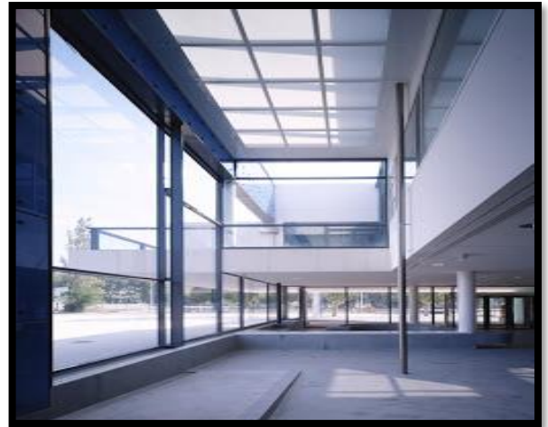
Figure V-32 : vélum vitré formant plafond d'un espace de grande hauteur.
