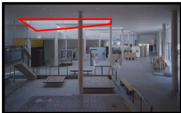
Figure V-13, V-14: des sheds dans les toitures qui réfléchissent l'éclairage sur les œuvres pour mettre en valeur les collections.
