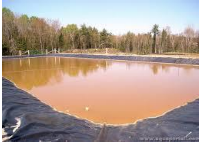
Figure II-3. Bassin de lixiviats d'une décharge. [24]
