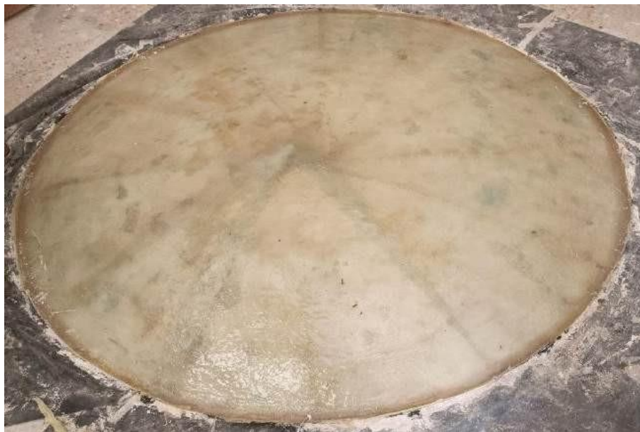
Figure IV-35 : Application de la résine et de la fibre de verre
