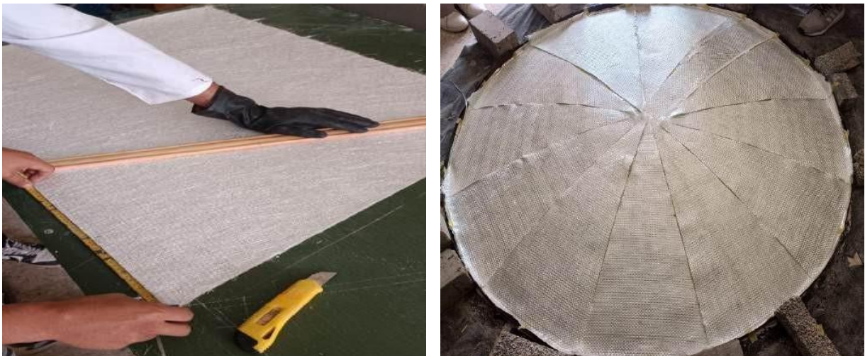
Figure IV-26 : Application de la fibre de verre
