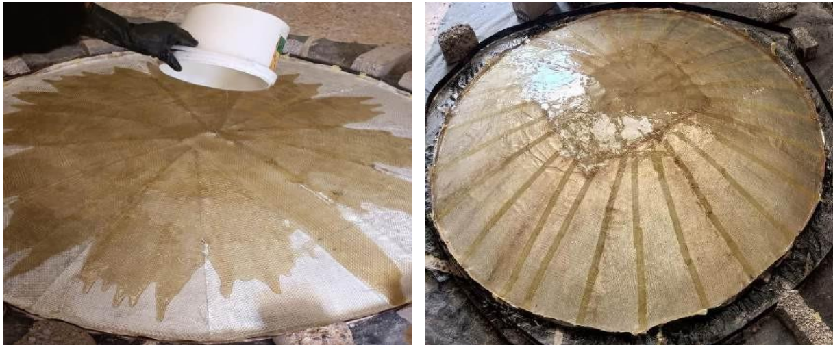
Figure IV-27 : Ajout d'une deuxième et troisième couche de résine
