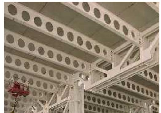
Figure95: poutre alvéolaire
