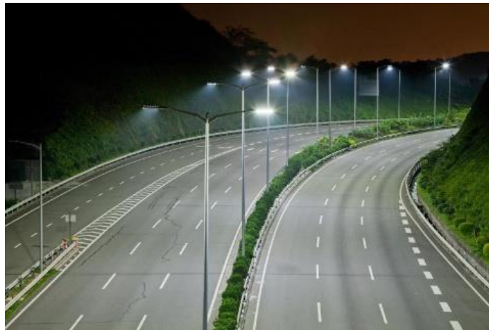
Figure 66 : Eclairage dans une autoroute
