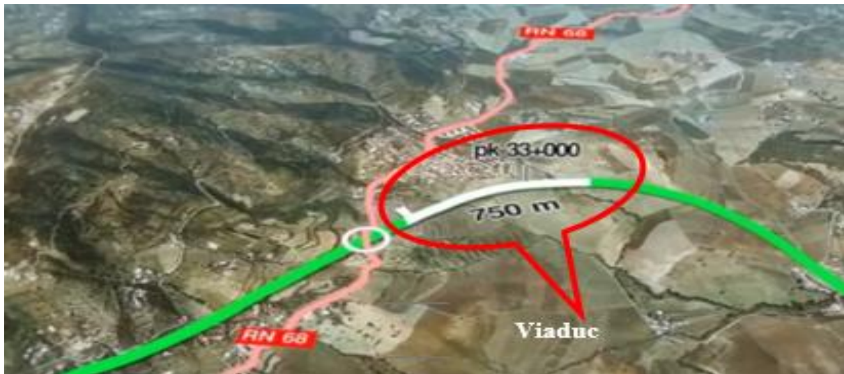
Figure 6 : Viaduc de 750 km au PK33. (ÎNŞAAT, 2019)
