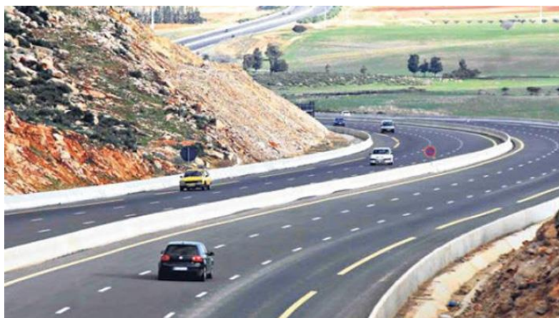
Figure 68 : Glissières de sécurité sur l'autoroute est-ouest
