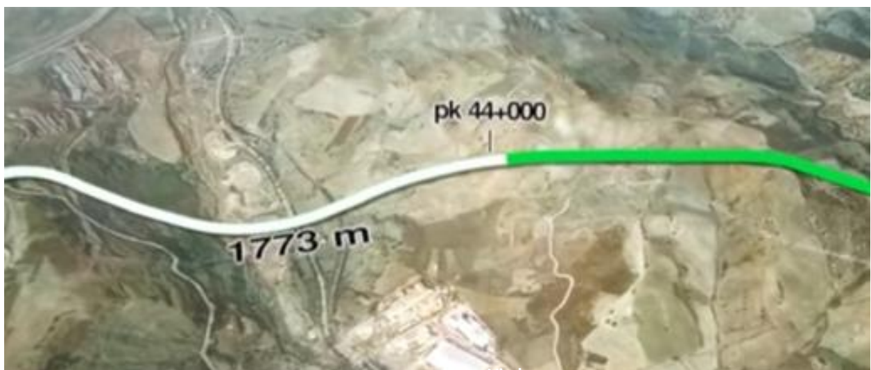
Figure 7 : Le Viaduc le plus long du tracé. (ÎNŞAAT, 2019)
