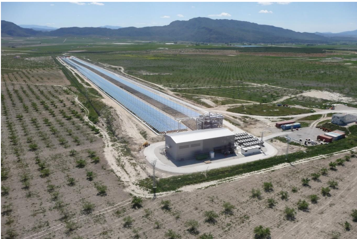
Figure 12 : Centrale Puerto Errado 1 d'1,4 MW utilisant des capteurs linéaires de Fresnel
