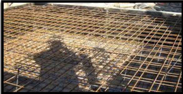
Figure 67 : détail de ferrillage d'un plancher à corps creux :
