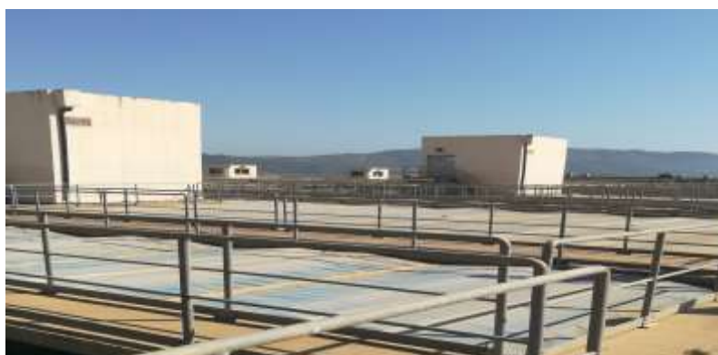
Figure III.13: Décanteurs (Pulsatub)
