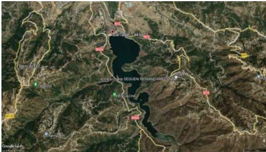
Figure III.1: Image satellitaire du barrage de Taksbet (Google Earth)
