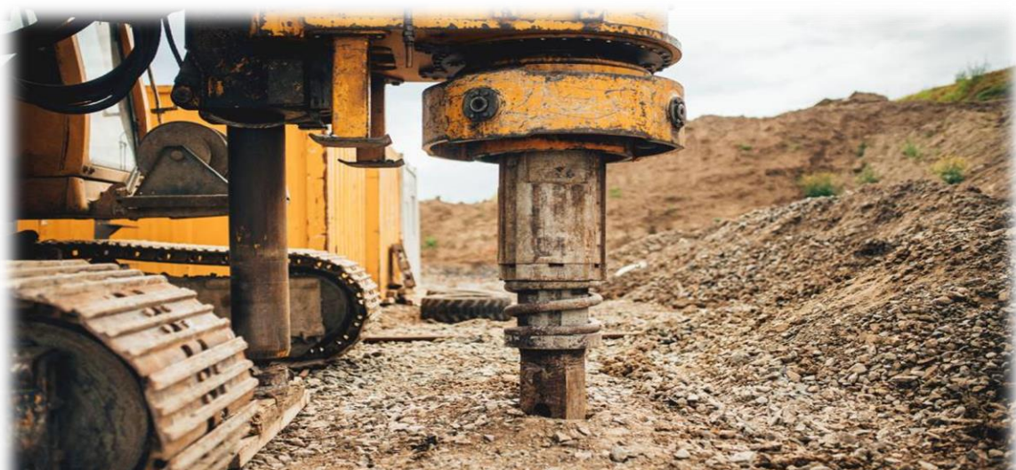
Figure15 : forage avec carottage
