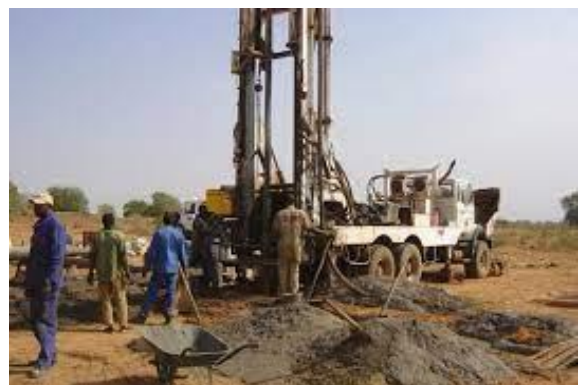
Figure25 : préparation du chantier de forage
