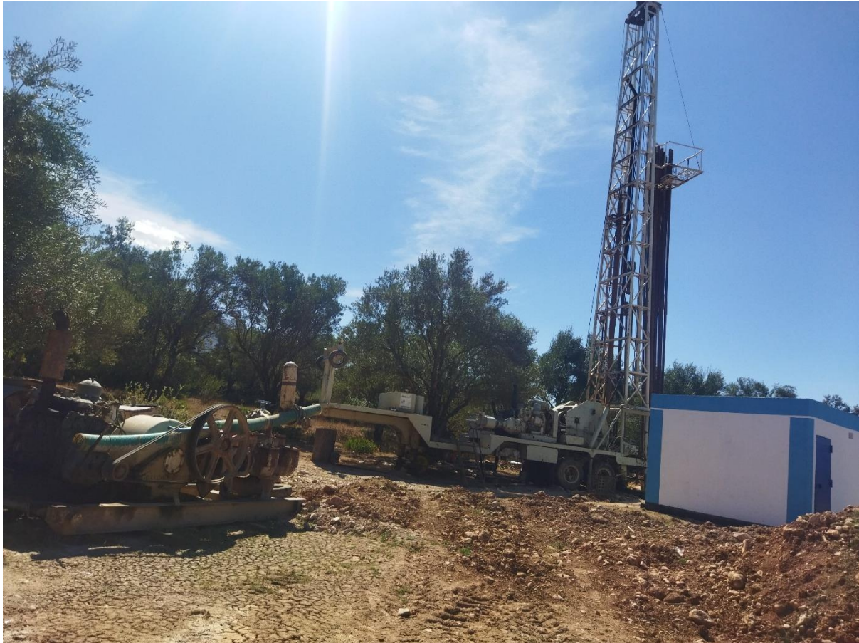
Figure 62 : Remise en état avant fin de chantier
