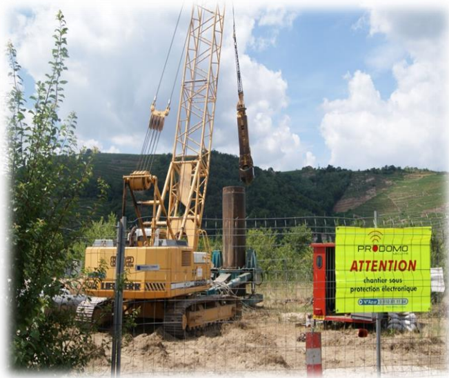
Figure 26 : Installation du chantier de forage
