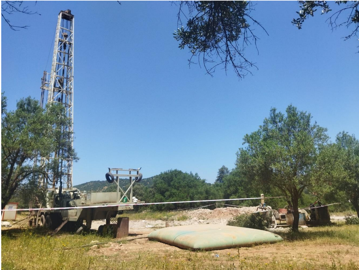
Figure 40 : le chantier de forage Alma Ndinar
