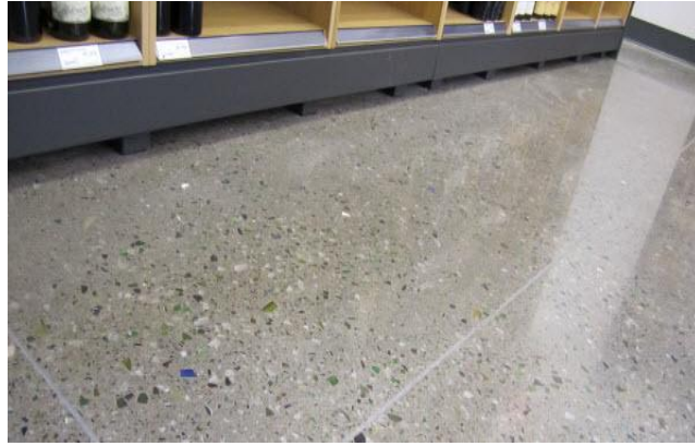
Figure I.1: Intégration de la poudre et des agrégats de verre recyclé dans les dalles de béton non structurales.
