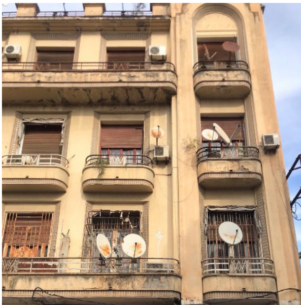
Photo 11: Façade d'un immeuble d'habitation (1)
