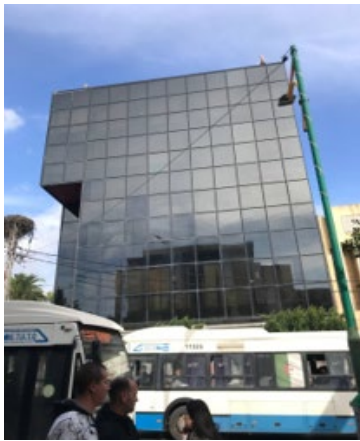
Photo 13: La CNEP Source : Auteur
