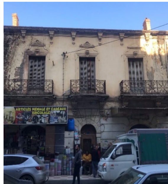
Photo 12: Façade d'un immeuble d'habitation (2)
