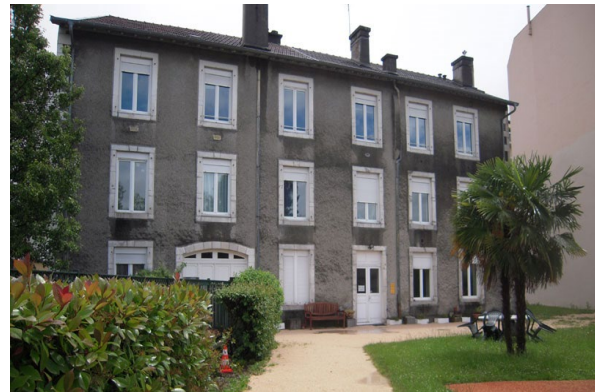
Photo 50 : Vue extérieure sur le centre Source :
