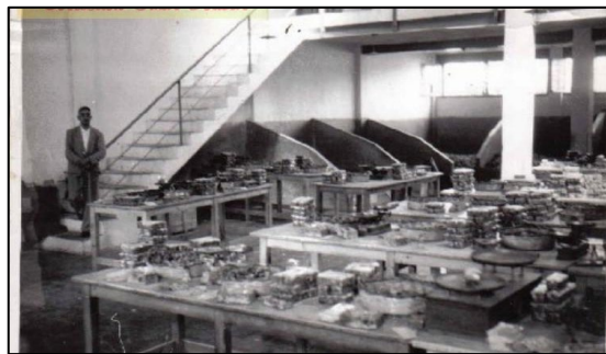
Photo 28: Local d'emballage Source : Archive de la ville collection Omar Bouzar Crescenzo
