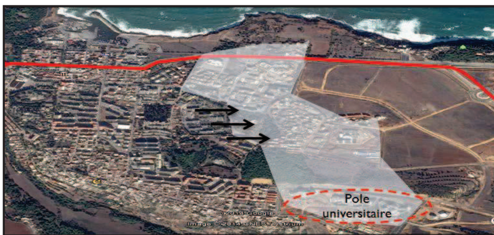
Fig13 : Vue aérienne de ville de Tipaza. Source : Google earth.
