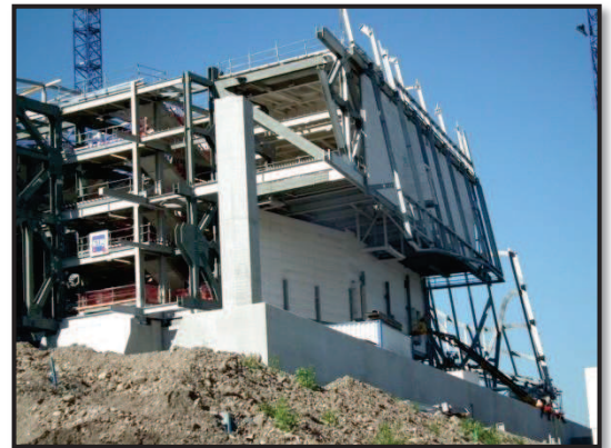
Fig 101 : La structure métallique du musée des confluences
