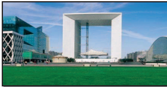
Fig.49:grand arche de la défense Source: Wikipédia
