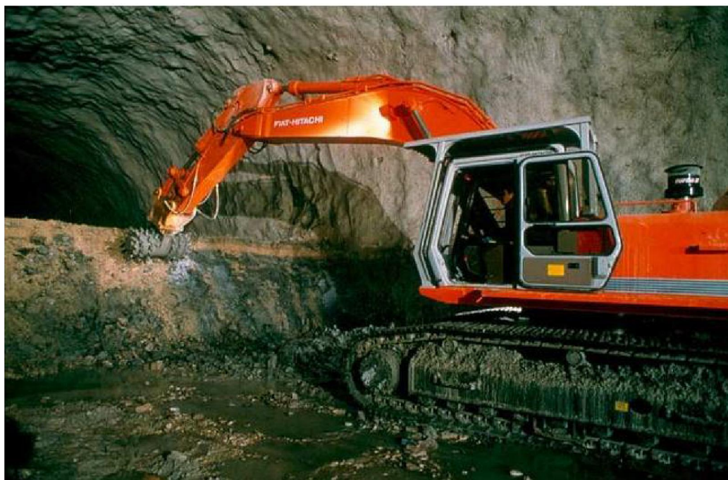
Figure I.5: Creusement en demi-section.
