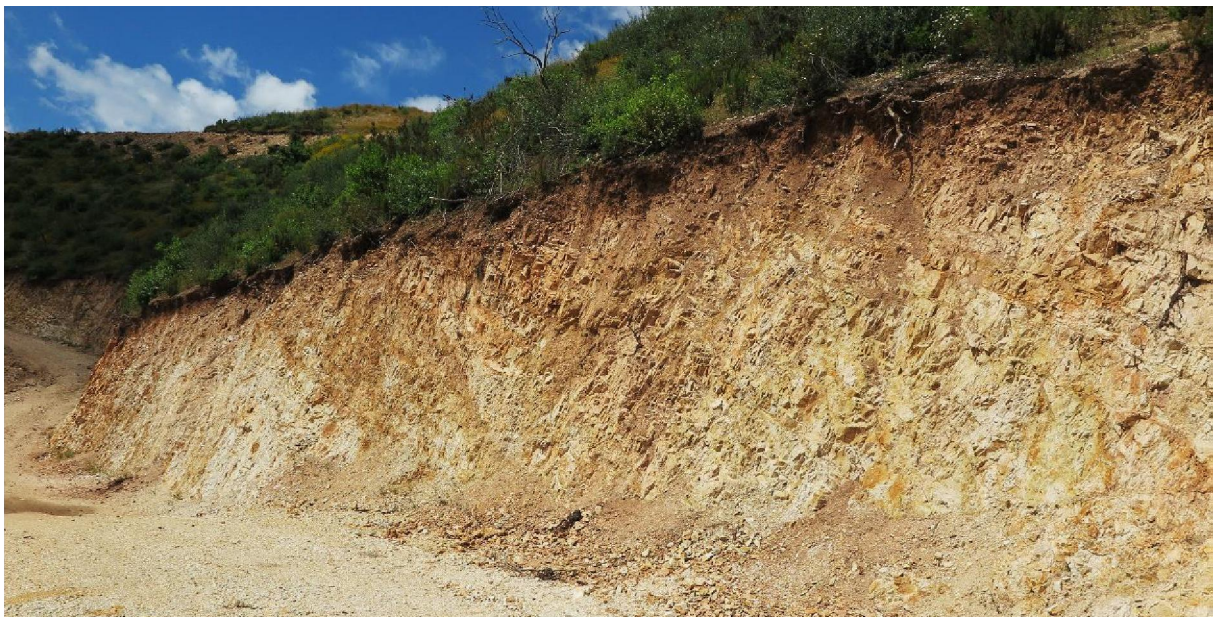
Figure II.5: Vue d'ensemble du portail d'entrée du tunnel Ait Yahia Mousa, aperçu vers l'ouest. Roches métagranites rencontrés dans l'excavation du front du tube droit et déblais verticaux ouverts sur la route d'accès.
