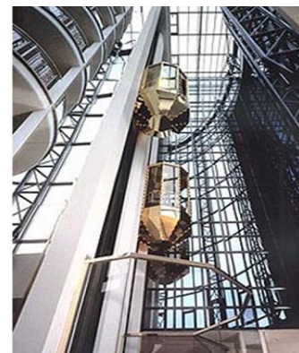
Fig. .ascenseur panoramique
