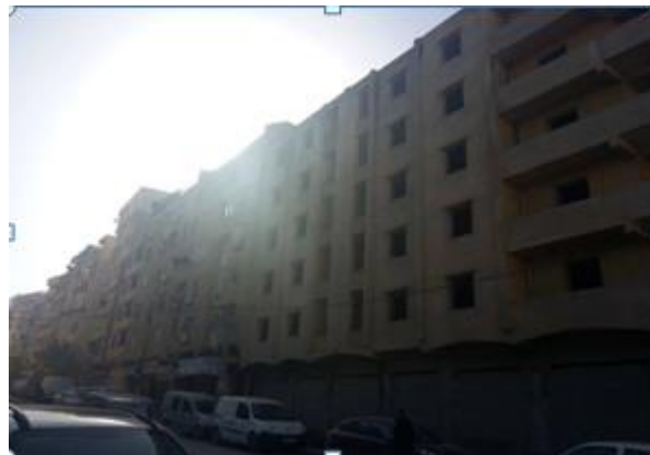
Des constructions dans la voie vers Bastos
