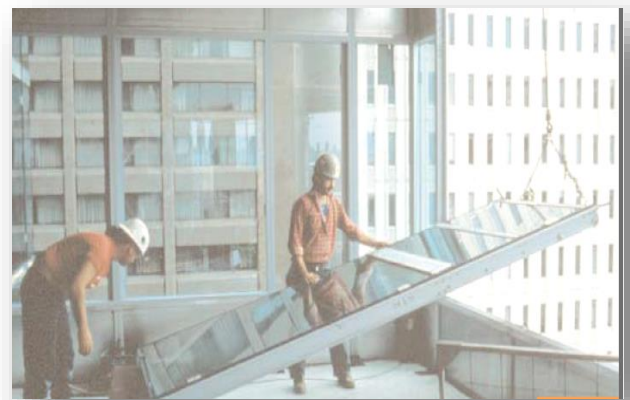
Fig: Installation d'un système de mur-rideau en panneaux
