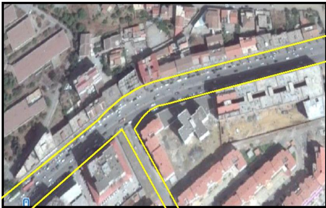
Vue aérienne montrant l'alignement du bâti par rapport aux voix
