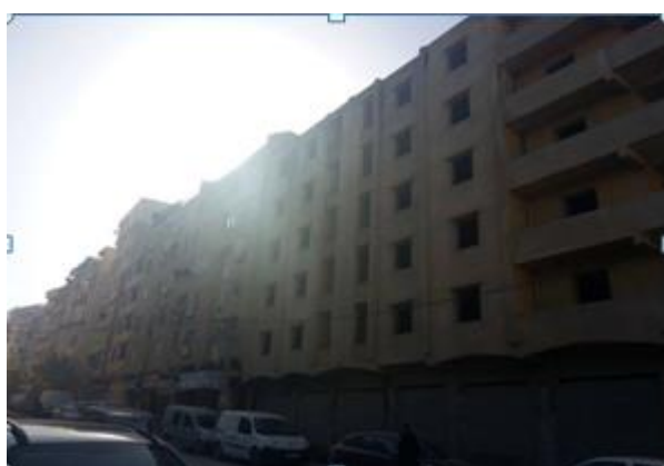
Des constructions dans la voie vers Bastos
