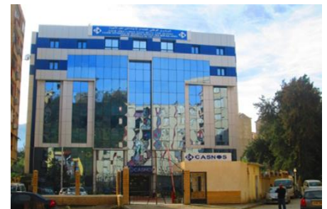
Siege de CASNOS : un repère remarquable et ce ci grâce à son aspect architectural qui en rupture avec celui du quartier.
