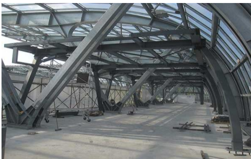
Fig.: poteaux métallique inclinés. source : Google.com.
