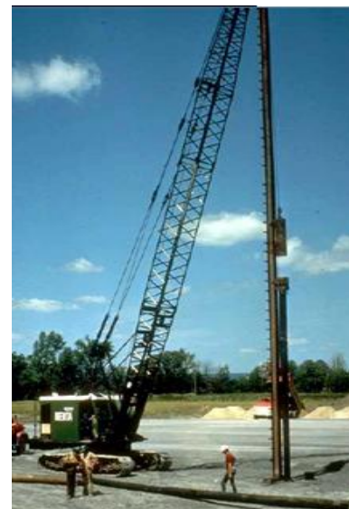
Figure I.4 : Equipement pour battage : Grue, mat, jumelle et casque.
