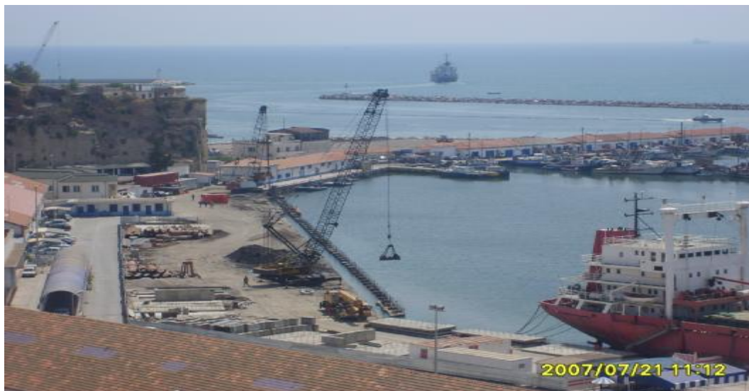
Figure II.9 : Rempiétement du quai nord de Bejaia.
