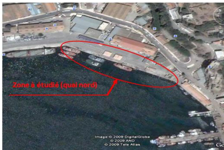
Figure 2 : Vue du quai nord du vieux port de Bejaia par satellite (Google)
