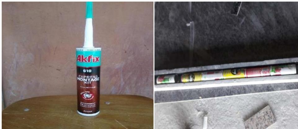
*Figure IV.20 : collage des cannetes avec le mastic de silicone.*
