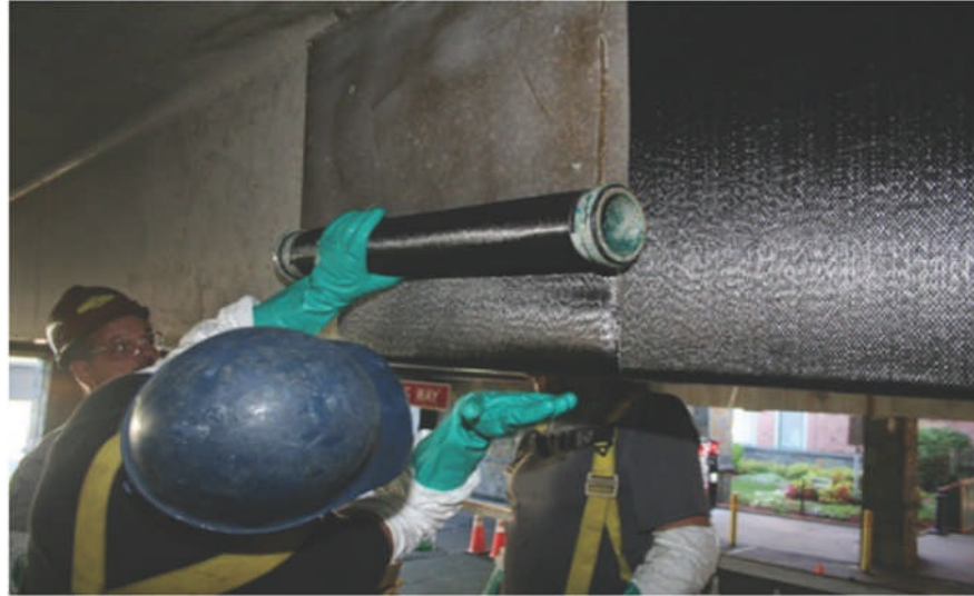
Figure I.16 : Renforcement en cisaillement d'une poutre
