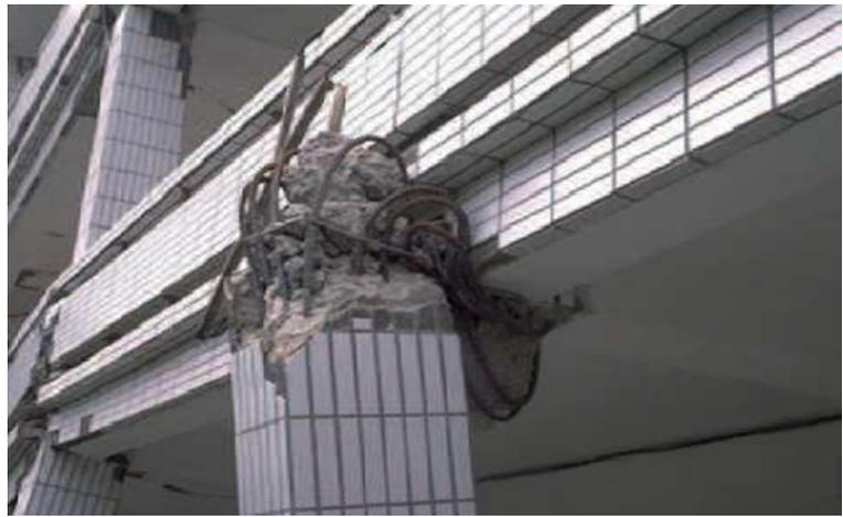
Figure 1.1 : Éclatement de zones critiques, extrémités des poteaux et poutres.
