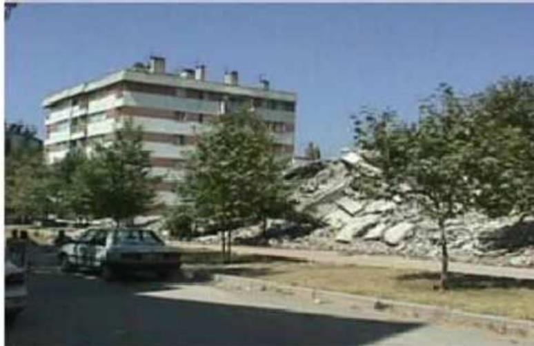
**Figure 1.2 : Comportement de deux immeubles voisins face aux secousses sismiques.**
