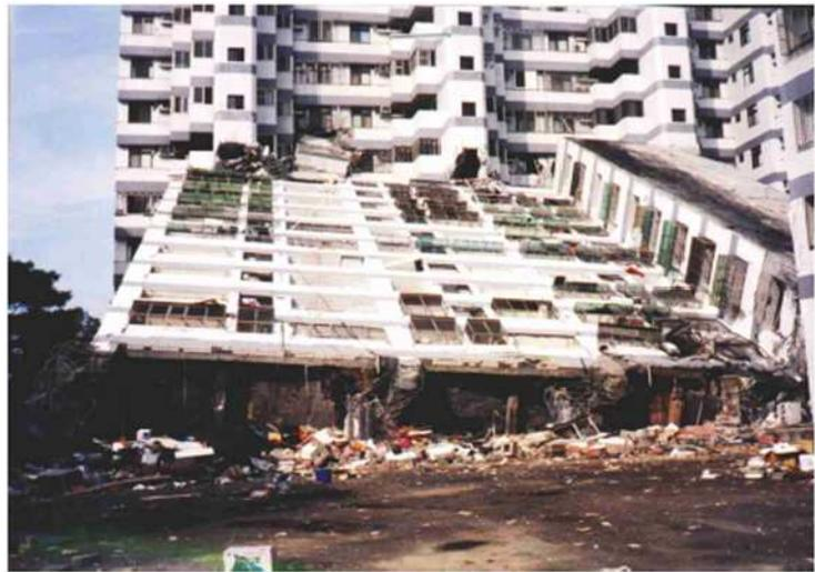
Dislocation des remplissages de maçonnerie d'une ossature en béton armé, ce mode de destruction « hétérogène » se comporte très mal sous l'action d'un séisme fort.
