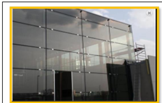
Figure 161:image représentante les murs rideaux source : auteurs
