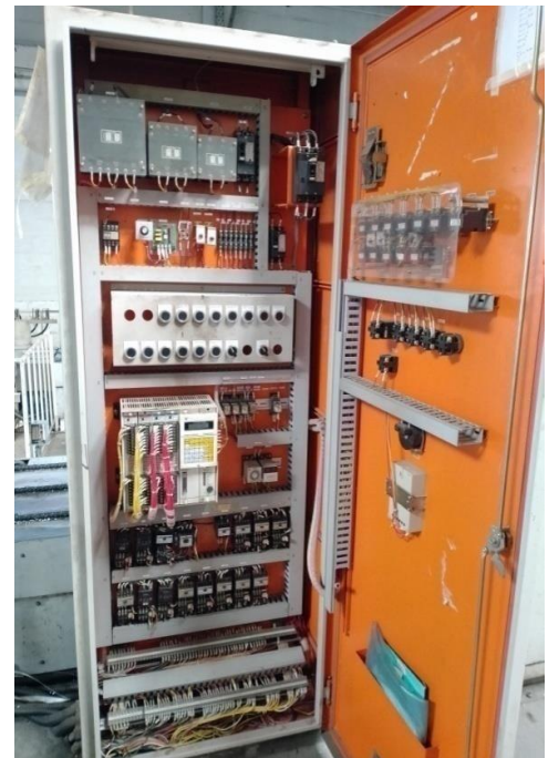
(b) armoire électrique de la rubaneus N°2.
