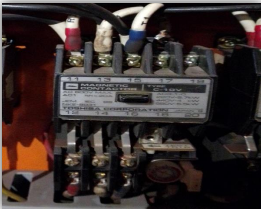
Figure 6. Contacteur et son symbole électrique.
