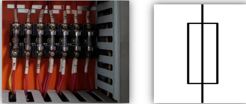
Figure 10. Fusible et son symbole électrique
