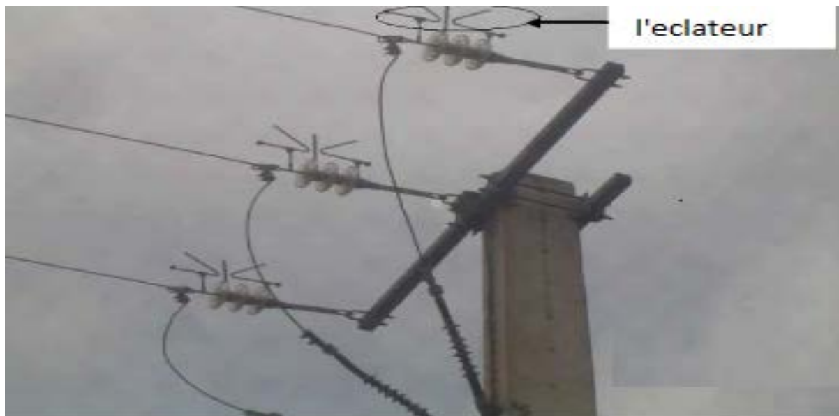
Fig.V-4- Eclateur MT avec tige anti-oiseaux.
