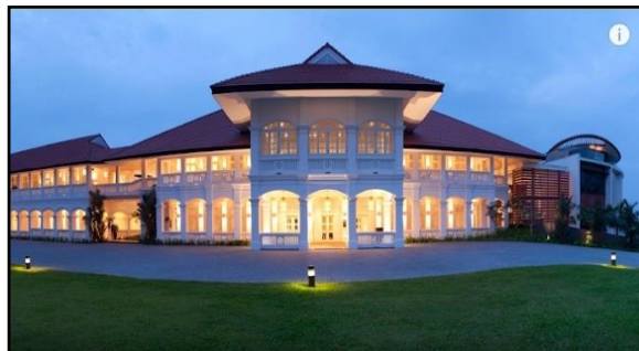
Figure II. 65 : Les bâtiments militaires Tanah Merah après la restauration.
