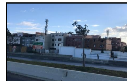
Figure I.55 : Constructions anarchiques. Source : Auteurs
