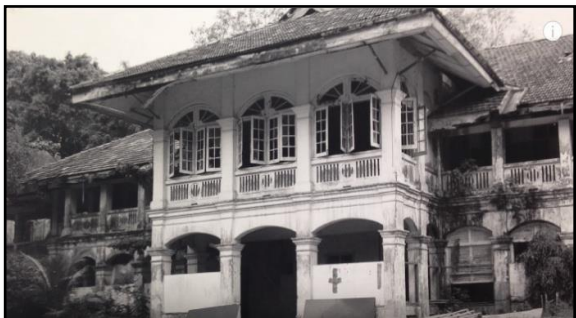
Figure II. 64 : Les bâtiments militaires Tanah Merah avant la restauration.
