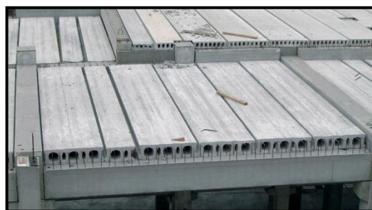
Figure IV.30. Dalle alvéolée en béton précontraint. Source : www.archiexpo.fr
