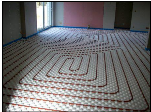
Figure III.35. Installation d'un plancher chauffant. Source : www.afc-climatisation.fr
