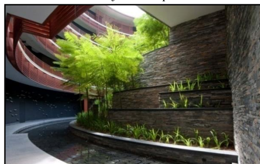
Figure II. 68 : Murs porteurs en pierre. Source : www.fosterandpartners.com
