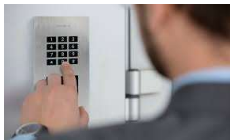
Figure I. 10 Contrôle d'Accès par Code PIN
