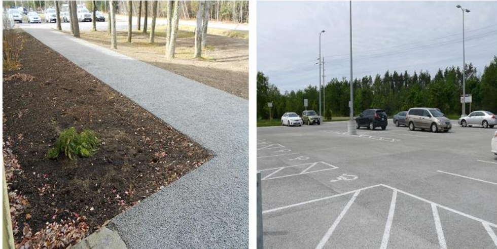
Figure II. 7: Domaines d'application des bétons drainants [34].
