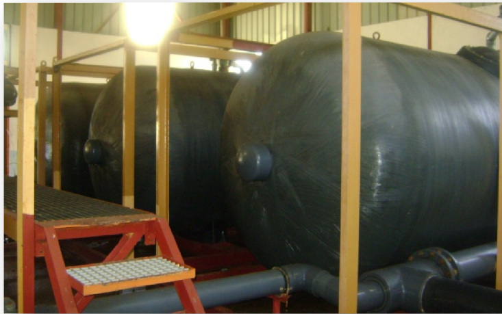
Photo 3 Image des trois filtres à sable
