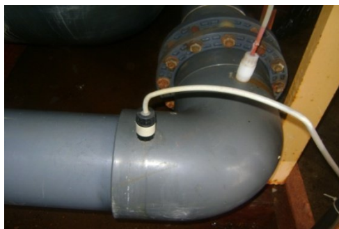
Photo 4 Point d'injection du bisulfite de sodium
