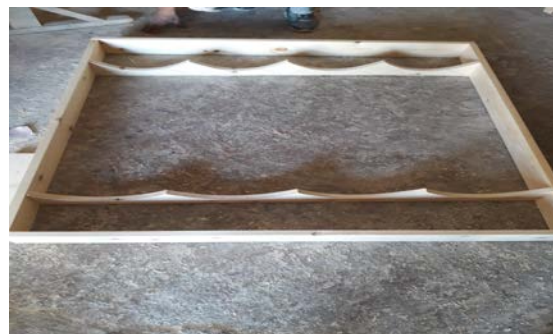
figure IV.16: cadre de la structure de basse
