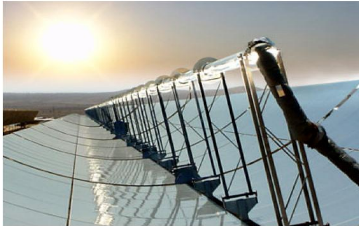
Figure III-16 concentrateur cylindo-parabolique de la centrale Nevada solar one (USA).
