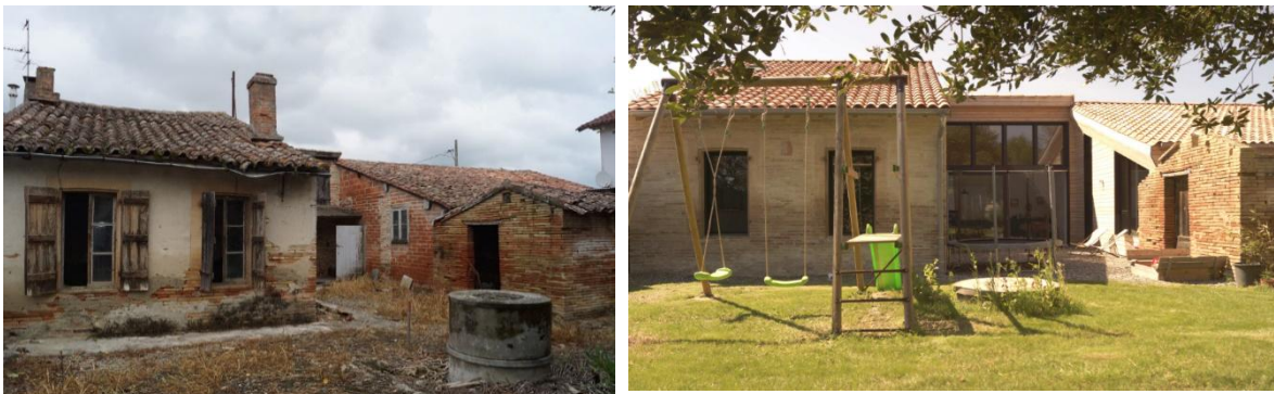
Fig.3.22-23. La transformation de la façade. Source. https://www.houzz.fr .
