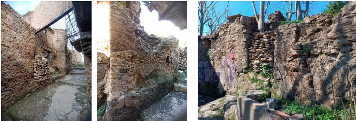
Fig.4.17-19. Vues extérieures de la maison 2. Source. Auteurs.
