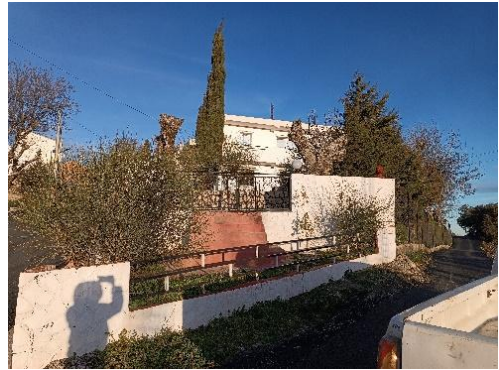
Fig.2.31-32. Façades de la maison M2. Source. Auteurs.
