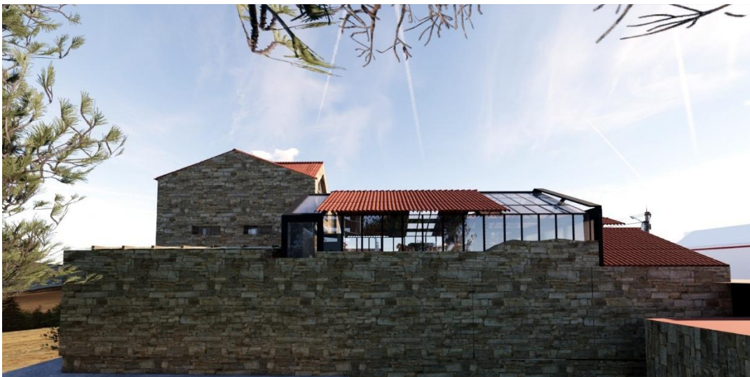
Fig.4.130. Façade latérale gauche. Source. Auteurs.
