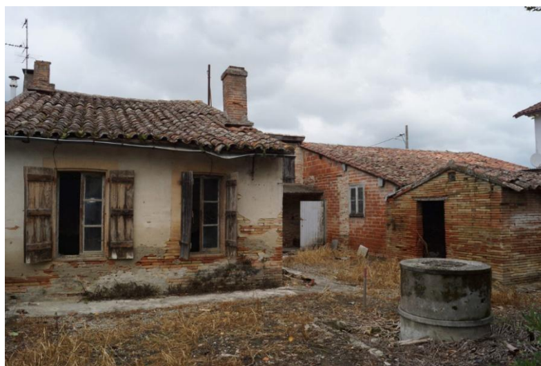
Fig.3.19. La maison avant les travaux. Source. https://www.houzz.fr .
