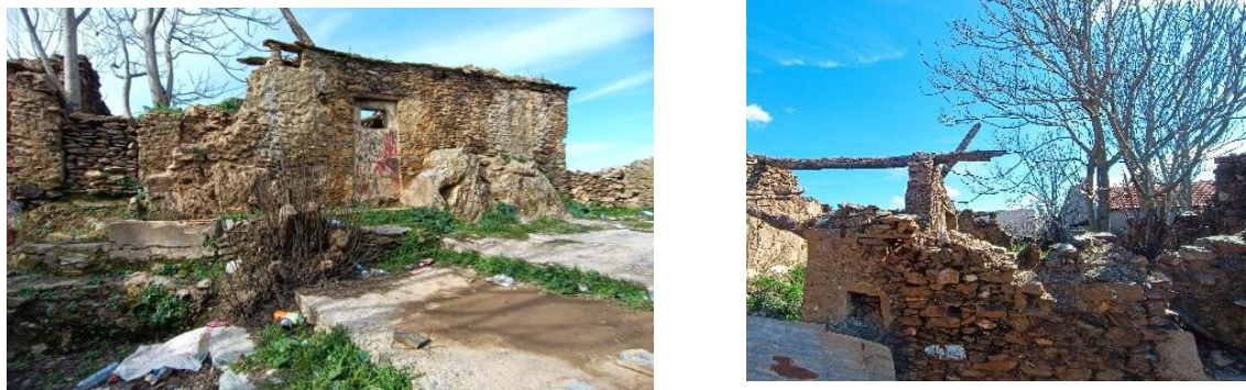
Fig.4.20-21. Vues extérieures de la maison 3. Source. Auteurs.
