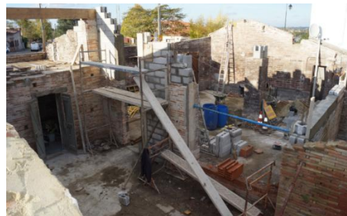
Fig.3.21. La maison durant les travaux. Source. https://www.houzz.fr .
