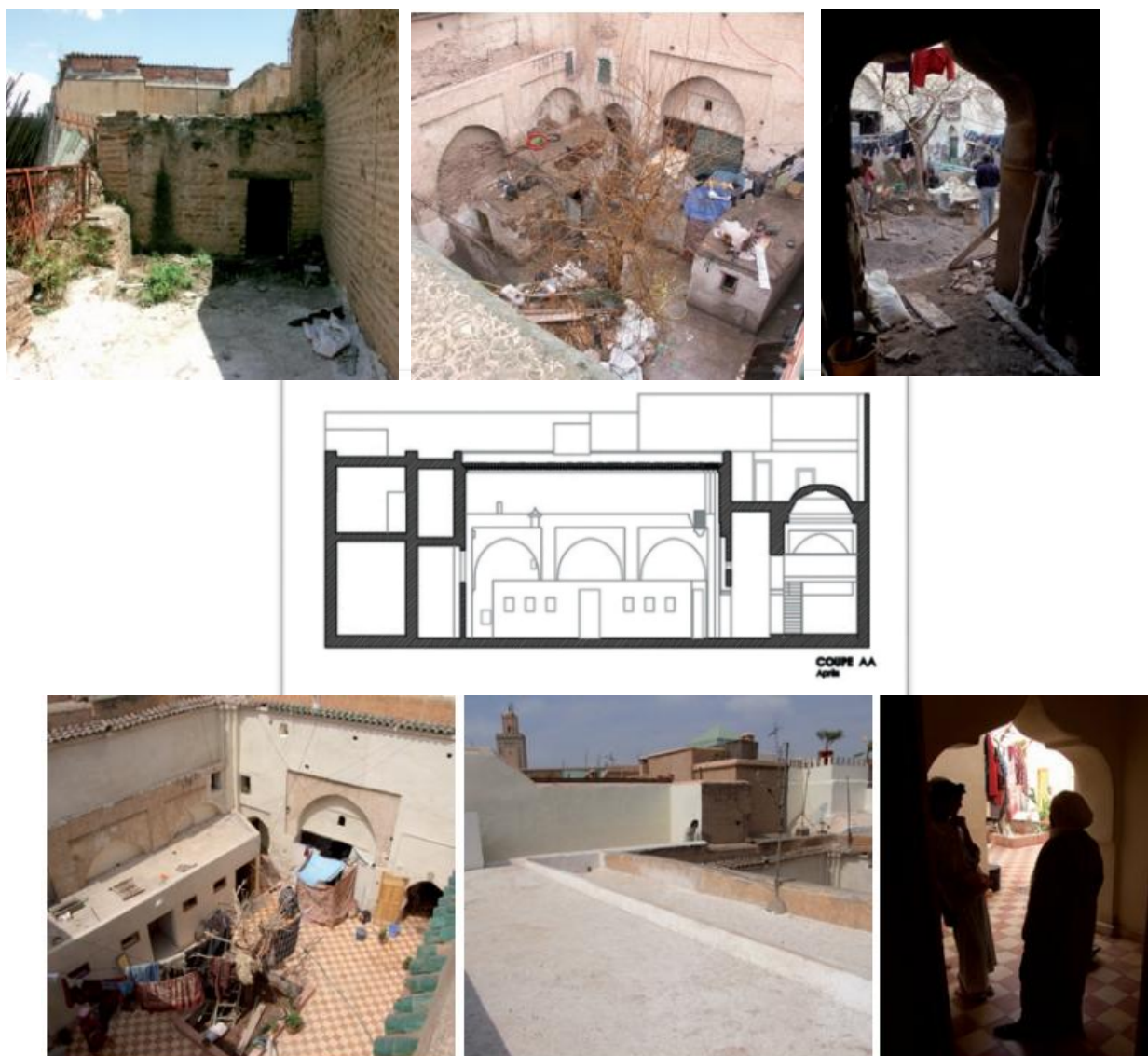
Fig.3.12-18. Les travaux de réhabilitation. Source. Réhabilitation et action sociale à Marrakech, Maroc.
