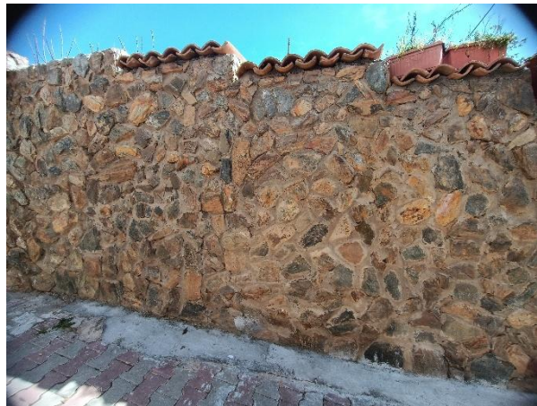
Fig.2.44. Habillage des murs en pierre. Source. Auteurs
