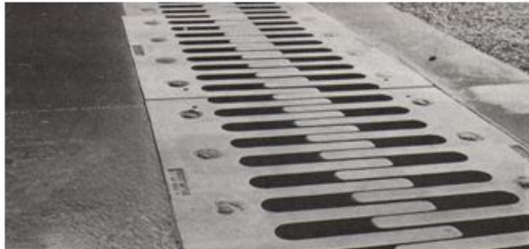
Fig. XV.7: Joint de chaussée
