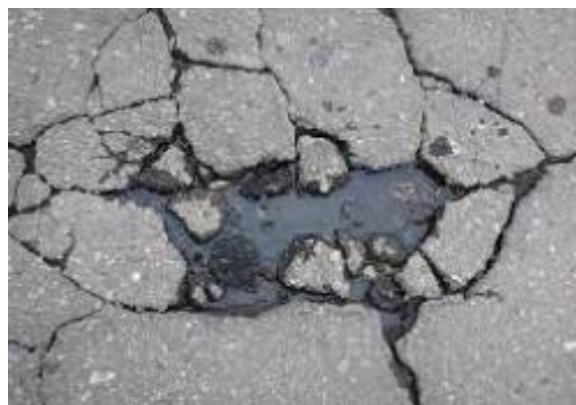
Figure 1. 26 Exemple d'un pelage dans la chaussée [30]
