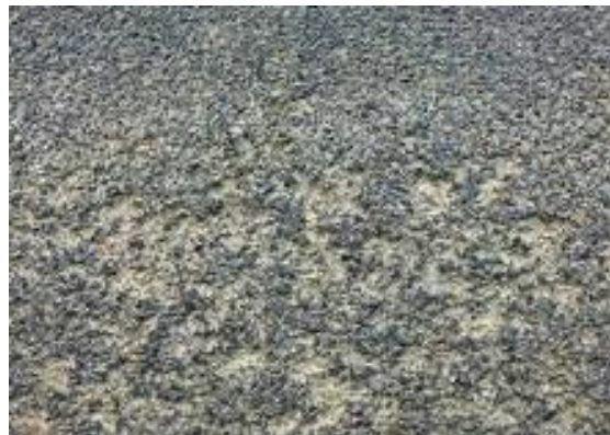
La figure 1. 25 Le plumage dans une chaussée [9]
