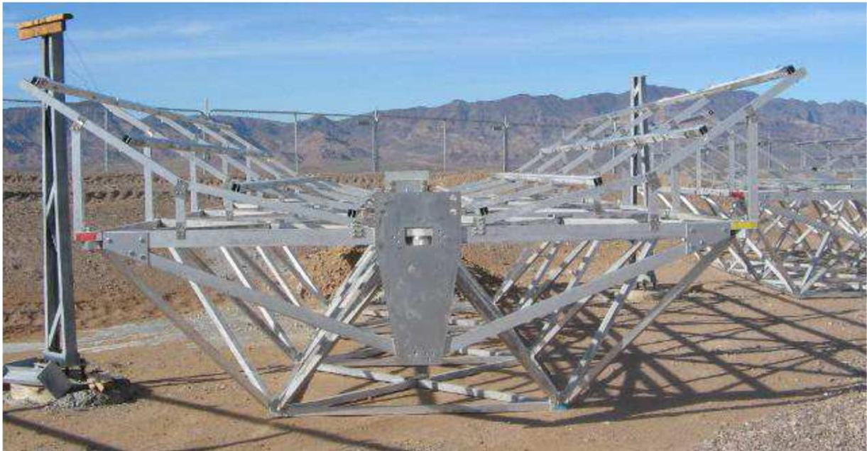
**Figure II.7:** Structure métallique d'un concentrateur cylindro-parabolique.
