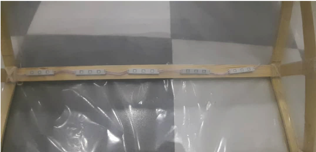
Figure 66 : L'état OFF des leds
