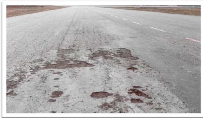
Figure 7.I. Dégradation d'arrachement.
