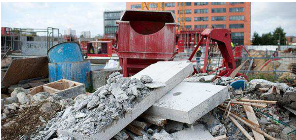
Figure 8.II. Déchets des chantiers de BTP.
