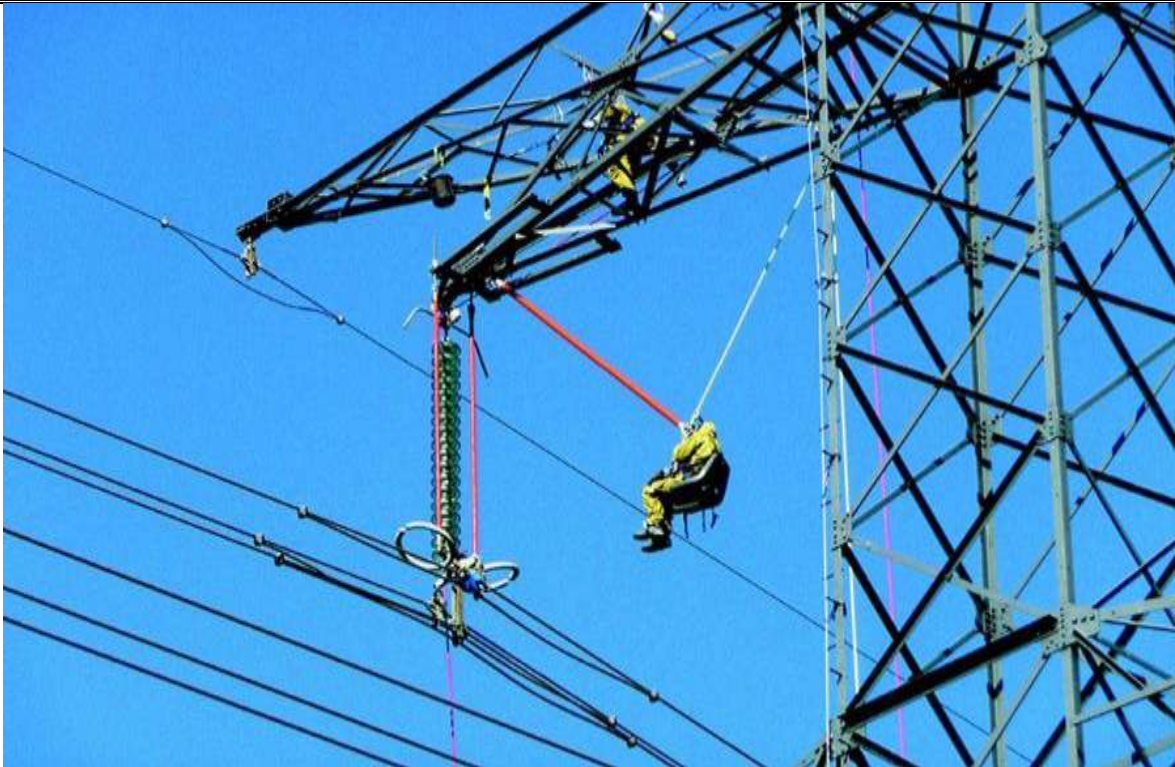
Figure. II.7: Entretien des chaînes d'isolateurs (lavage).
