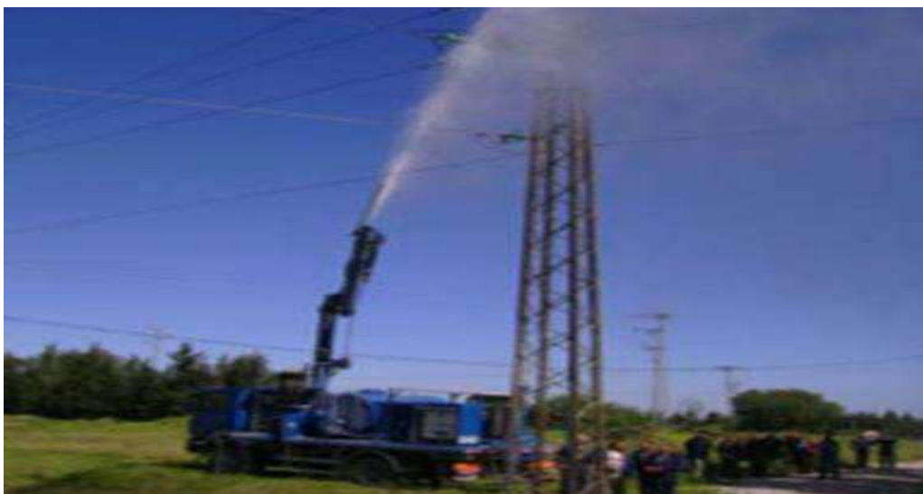
Figure. II.8 : Nettoyage des isolateurs de ligne haute tension.
