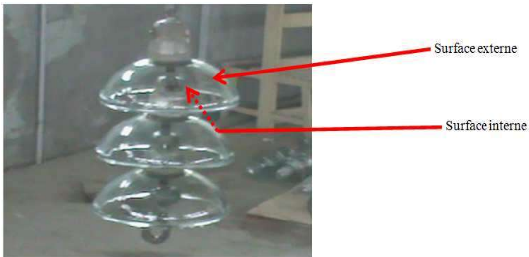
Figure III.3 : Surfaces interne et externe d'un élément de la chaîne d'isolateur.
