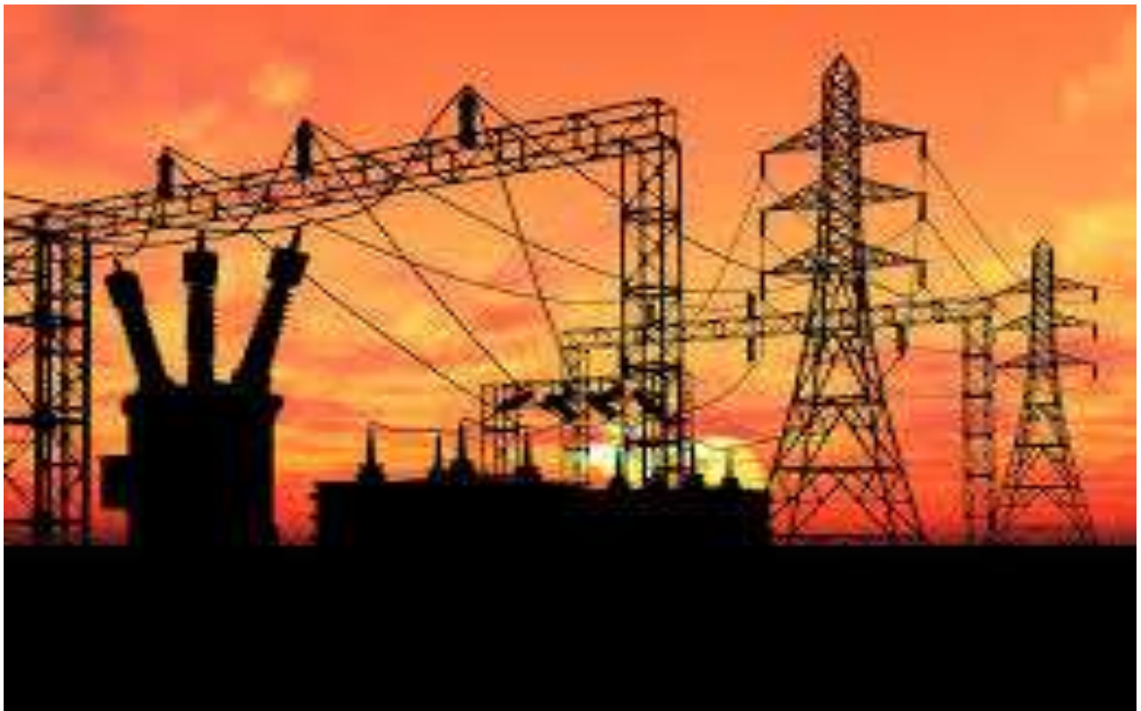
Figure II.3 : Lignes haute tension soumises à la pollution industrielle.
