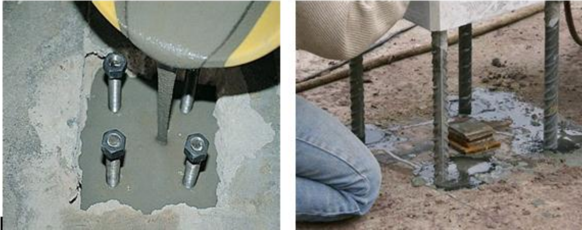
Figure .I.11. Les scellements et les calages.
