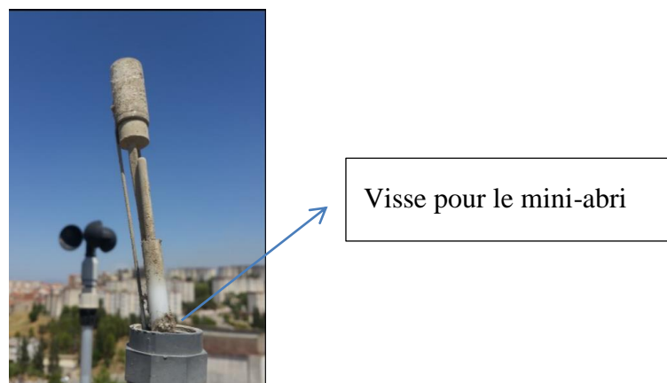
Figure 4 .Montage des sondes d humidité et de tempirature
